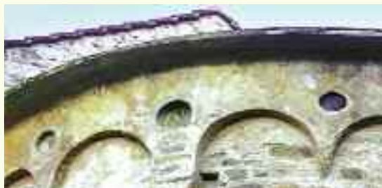
Particolare dell'abside, San Paragorio, Noli.
