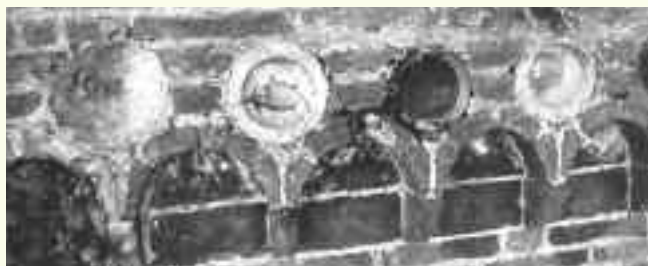
San Michele degli Scalzi, Savona, campanile lato nord, ultimo quarto XII sec.
